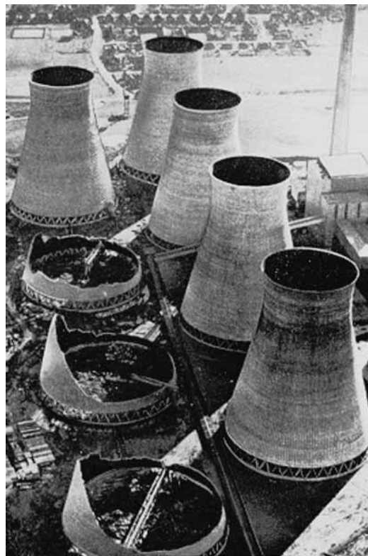
Abb. 3 Versagen einer Kühlturmgruppe in Ferrybridge (England, 1965)
