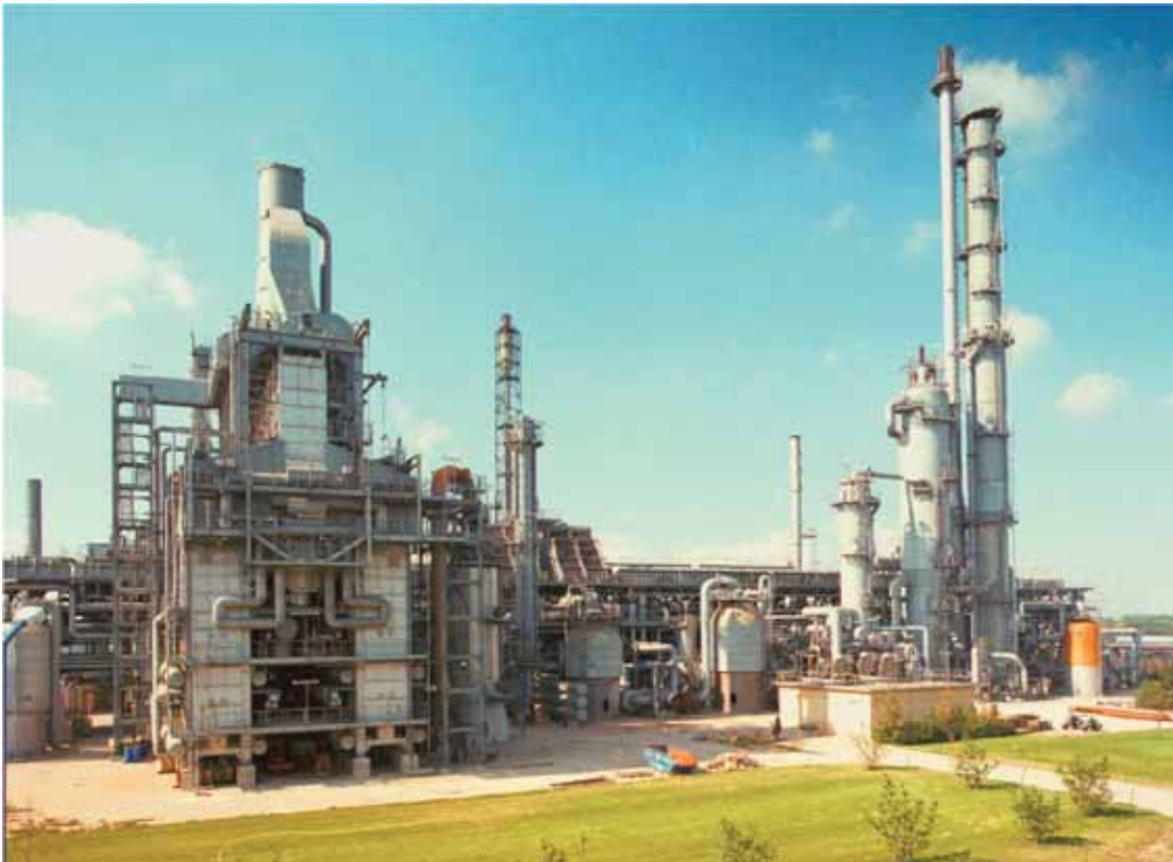
Abb. 1 Ansicht einer modernen Ammoniak-Fabrik (Quelle: BASF AG)
