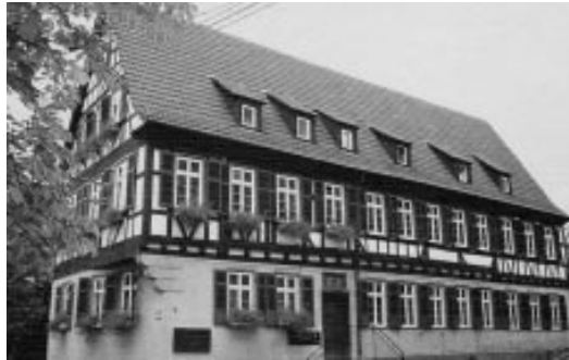
Abb. 2 Die Lateinschule zu Kirchheim unter Teck (erbaut um 1540). (Schriften- reihe des Stadt- archivs Kirchheim unter Teck 6, 1987, Umschlagbild)
