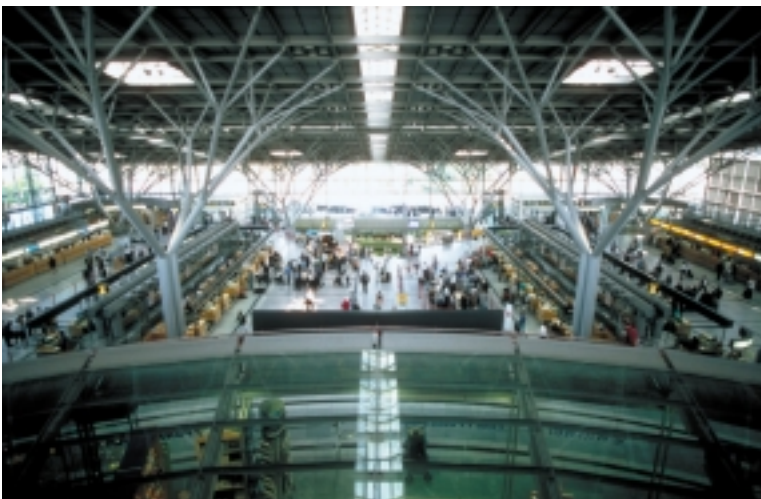
Abb. 10 Stählerne Baum- strukturen tragen das Dach des Flughafens Stuttgart
