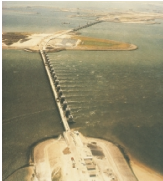
Abb. 1 Das Oosterschelde-Sperrwerk des Delta-Projekts in den Niederlanden. Die 3.000 m lange Flutbarriere besteht aus 65 vorgefertigten Betonpfeilern mit 62 stählernen Wehrklappen dazwischen. Foto: Das Sturmflutwehr in der Oosterschelde, Rijkswaterstaat, Holland
