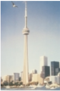
Abb. 3 Der z. Zt. höchste Turm der Welt (553 m), der CN-Tower in Toronto. Foto: E. Heinle u. F. Leonhardt, „Türme aller Zeiten, aller Kulturen“, Deutsche Verlags-Anstalt Stuttgart 1988
